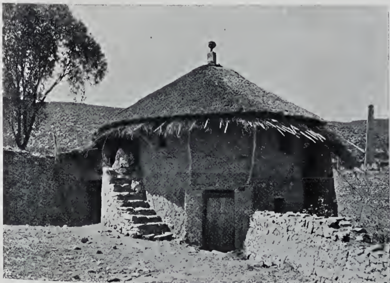
Abb. 107. Einräumig-zweigeschossiges Rundhaus. Aksum.
